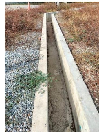
รูปที่ 2-11 บ่อพักรวบรวมตะกอนคอนกรีต
