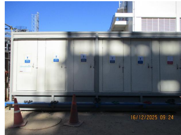
รูปที่ 2-9 ห้องน้ำ ห้องส้วม พร้อมระบบบำบัดน้ำเสียสำเร็จรูปแบบเคลื่อนที่
