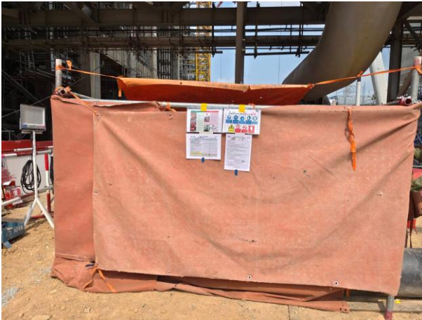
รูปที่ 2-4 การปิดคลุมด้วยผ้าใบทุกด้านเพื่อป้องกัน Copper slag ฟุ้งออกจากพื้นที่ปฏิบัติงาน
